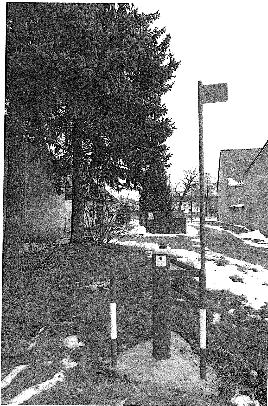
Beispielfoto: Ausbau einer Grundwassermessstelle als Überflurmessstelle
