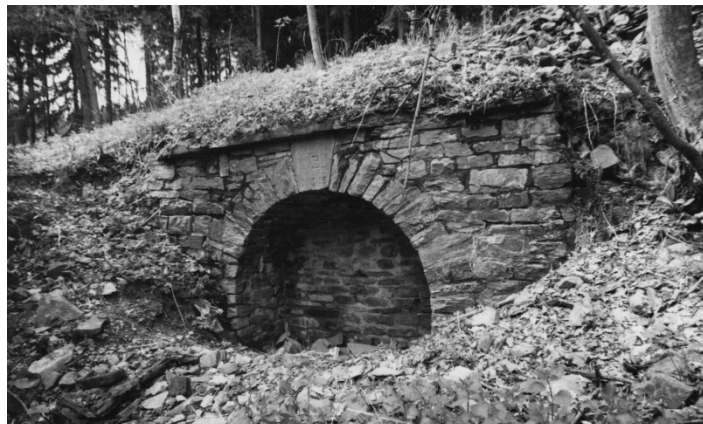
Mundloch des "Engländerstolln" nach der Verwahrung 1991.
