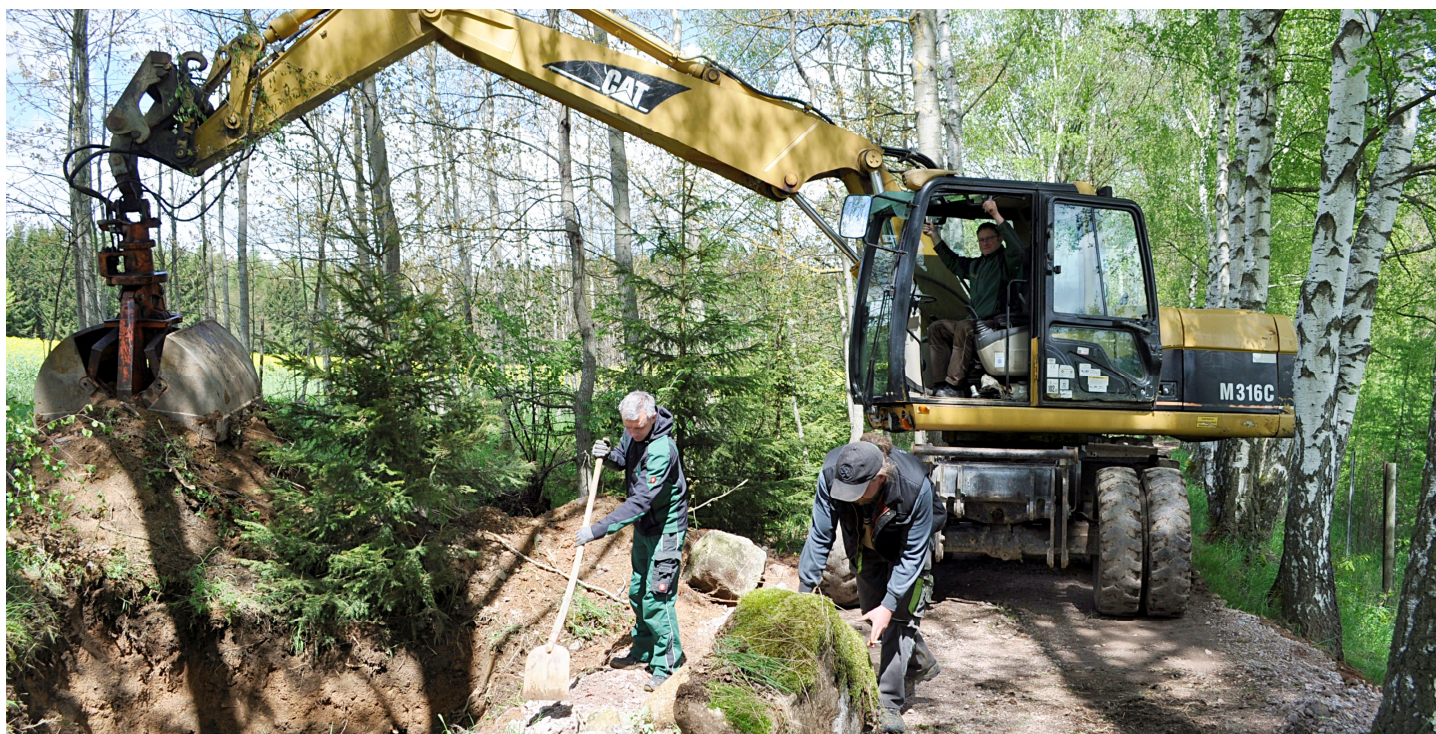
Ulf Passauer und sein Team bauen den Wendeweg aus. Künftig soll er auch als Radweg genutzt werden.
